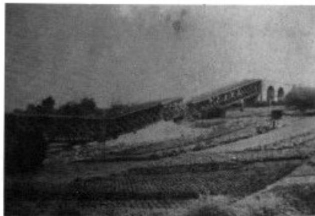
Viaduc Saint-Léger, le 25 août 1944, après le départ des Allemands
