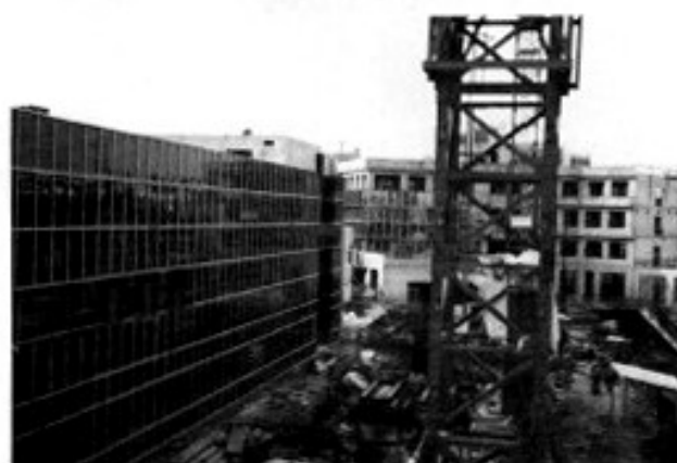
Immeuble de bureaux Kaufman et Broad en construction
