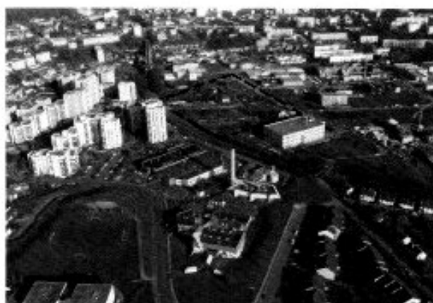
Vue aérienne de l'emplacement de la future gare de Bel Air
